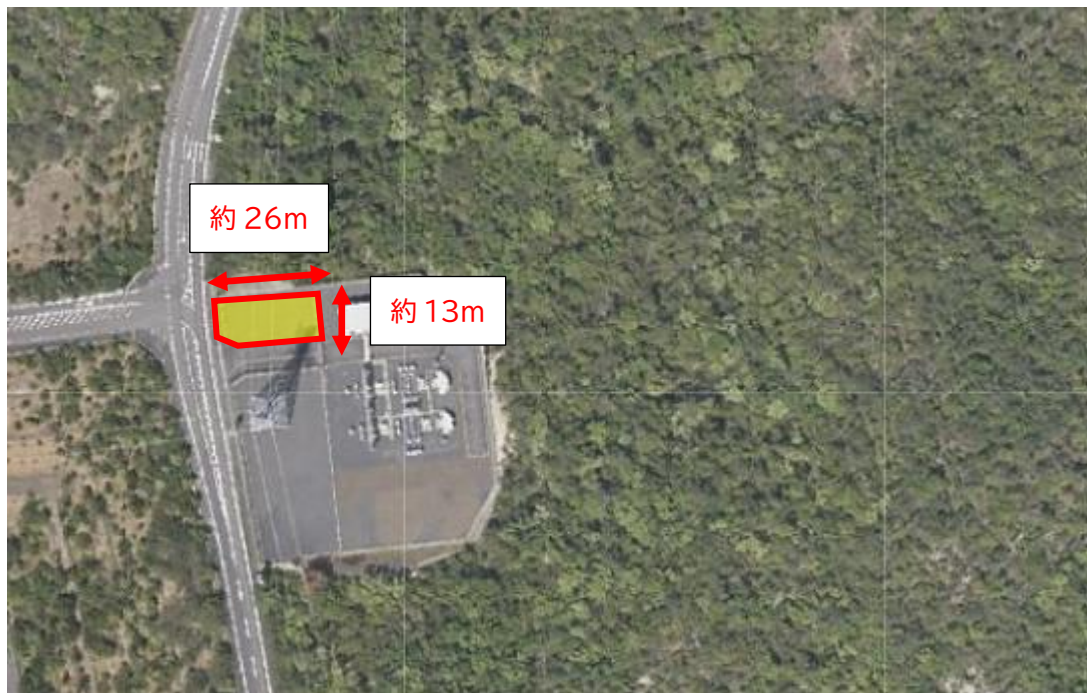
泉北変電所 構内
