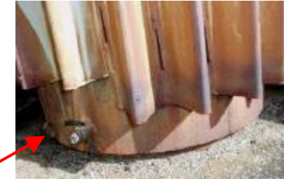
変圧器底面に油にじみ発生
