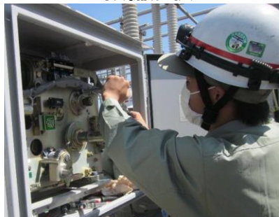
開閉器機構部の手入れ
