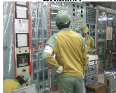
Ry装置の動作特性を測定
