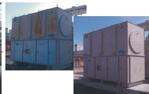
変電機器塗装
