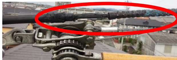
電線接続箇所の劣化
