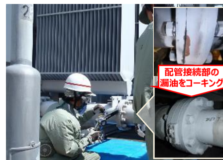
変圧器漏油修理
