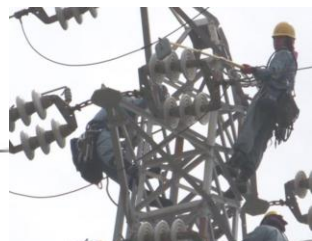
昇塔による点検
