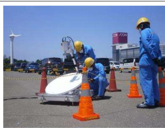
衛星回線を活用した通信回線設置
