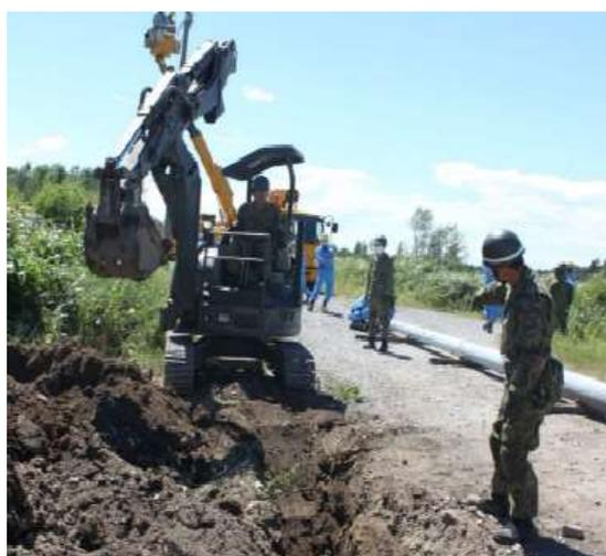
電柱建て込み場所の掘削作業
