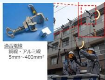
仮復旧工具の仕様統一
