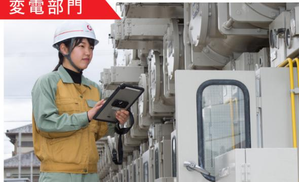
発電所から高い電圧でお客様の街まで届けられた電気を、工場やビル、ご家庭に電気を届けるため、使いやすい電圧に下げる役割を担っています。電力ネットワークの拠点である変電所でトラブルが発生すると大規模停電につながる可能性があるため、巡視や点検で小さな異常を把握し、電力の安定供給に支障がないよう事前に対処しています。
