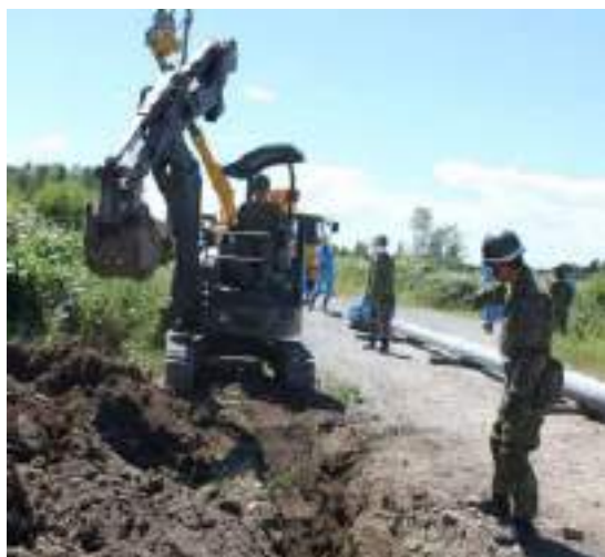
電柱建て込み場所の掘削作業
