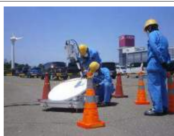
衛星回線を活用した通信回線設置
