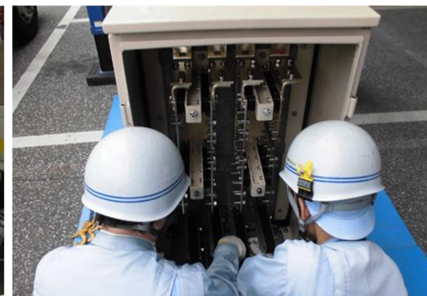
変圧器塔扉外し(同時並行作業)
