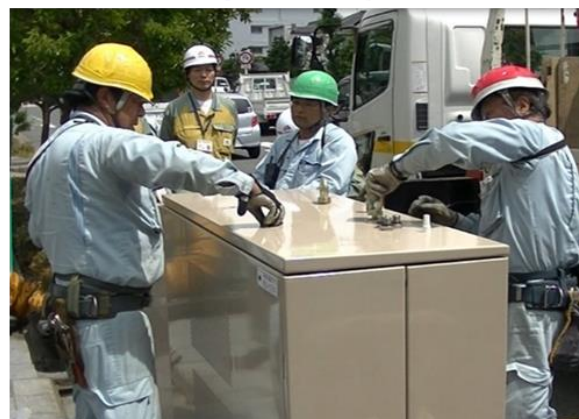
アイボルト外し、化粧ボルト外し (事前作業)
