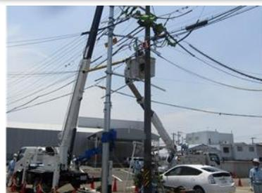
電柱の元位置建替工事の工期短縮を指向した車両であり、電柱建替工事のコスト低減が可能となります(従来は別位置へ仮移設した後、別日に再度元位置へ移設が必要です)
